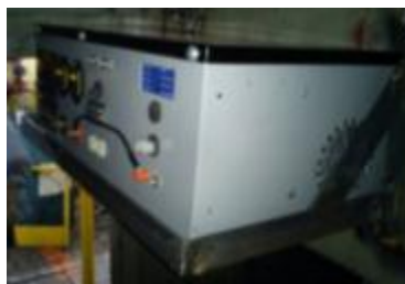
Ilustración 1. Inversor fijo en su pie de amigo.
