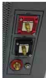
Imagen 2: Caperuzas de protección removidas
